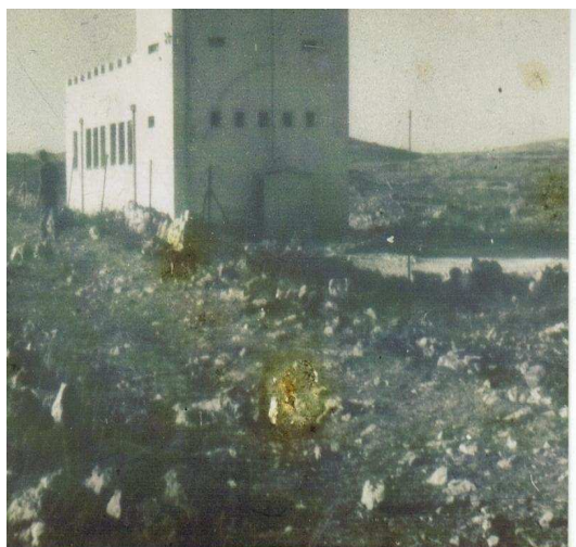
איור 5 : נווה יעקב – מבנה ציבורי ובית הכנסת
